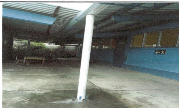
Foto: 4 colocación de canales y bajada de aguas pluviales
