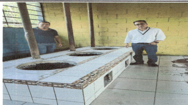
Foto: 5 colocacion de azulejos terminado
