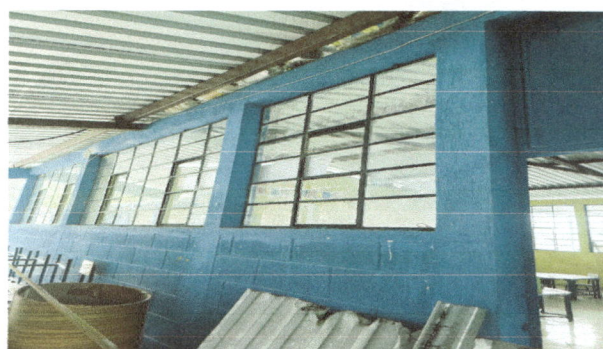
Foto: 2 estructura de techo culminado
