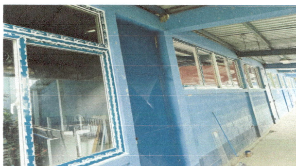
Foto: 3 ventanas PVC instalados
