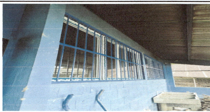
Foto: 6 colocacion de ventanas pvc y balcones de metal en la cocina, terminada
